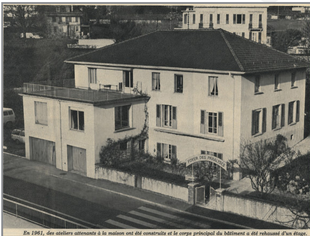
En 1961, des ateliers attenants à la maison ont été construits et le corps principal du bâtiment a été rehaussé d'un étage.
